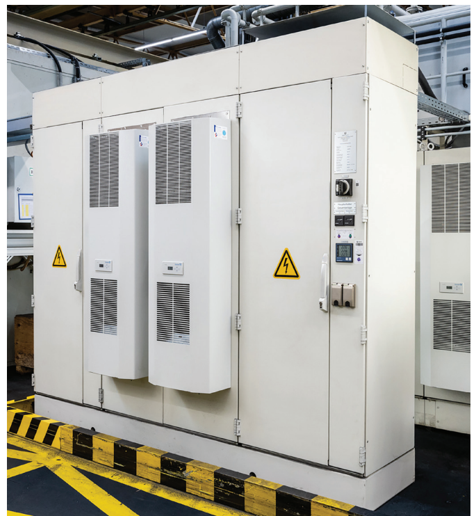
Bild rechts: Die X-Series Geräte sind als Standard erhältlich und ausschnittskompatibel mit Kühlgeräten der Green Series. Das ermöglichte eine schnelle Umrüstung der Geräte bei laufendem Maschinenbetrieb.
