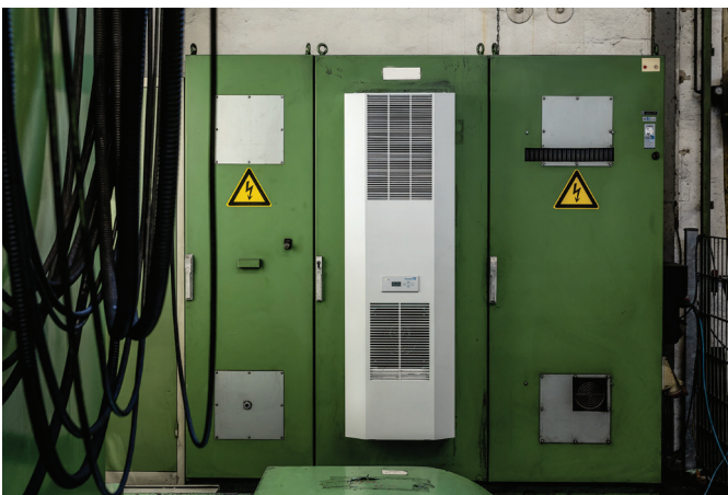
Bild oben: Ein Kühlgerät DTS 6X1E am Schaltschrank für eine Fräsmaschine.
