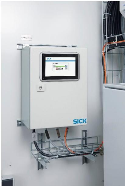
Bildunterschrift: Der Meeting Point Router (MPR) von SICK ermöglicht die ortsunabhängige Fernwartung der kommunikationsfähigen Kühlgeräte von Pfannenberg. Bild © SICK AG.
