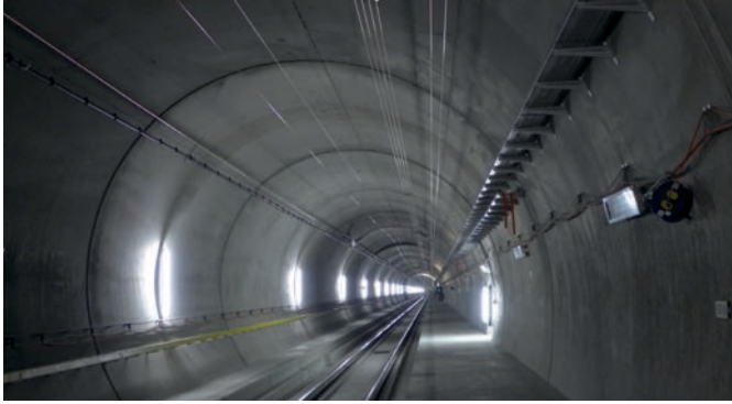
Abb. 1: Innenansicht Gotthard Tunnel
