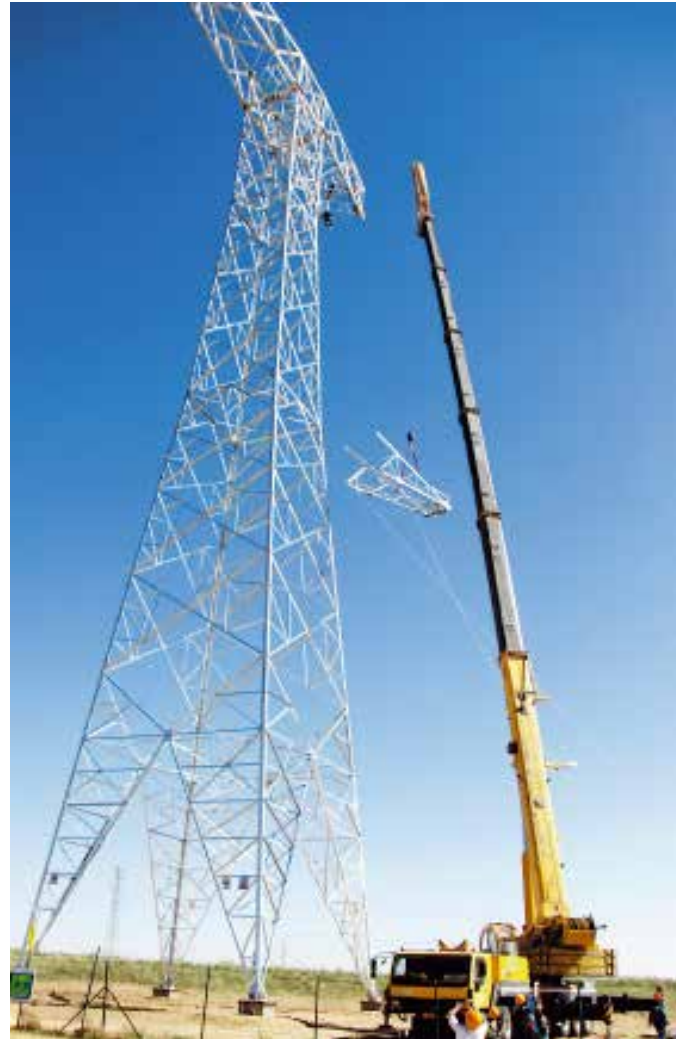
Bau der UHVDC-Leitung zwischen Lingzhou und Shaoxing auf einer Strecke von mehr als 1.600 km
