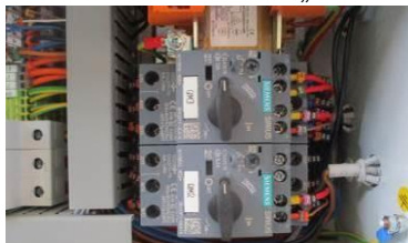
Abbildung 12 – Pumpenschalter auf ON
